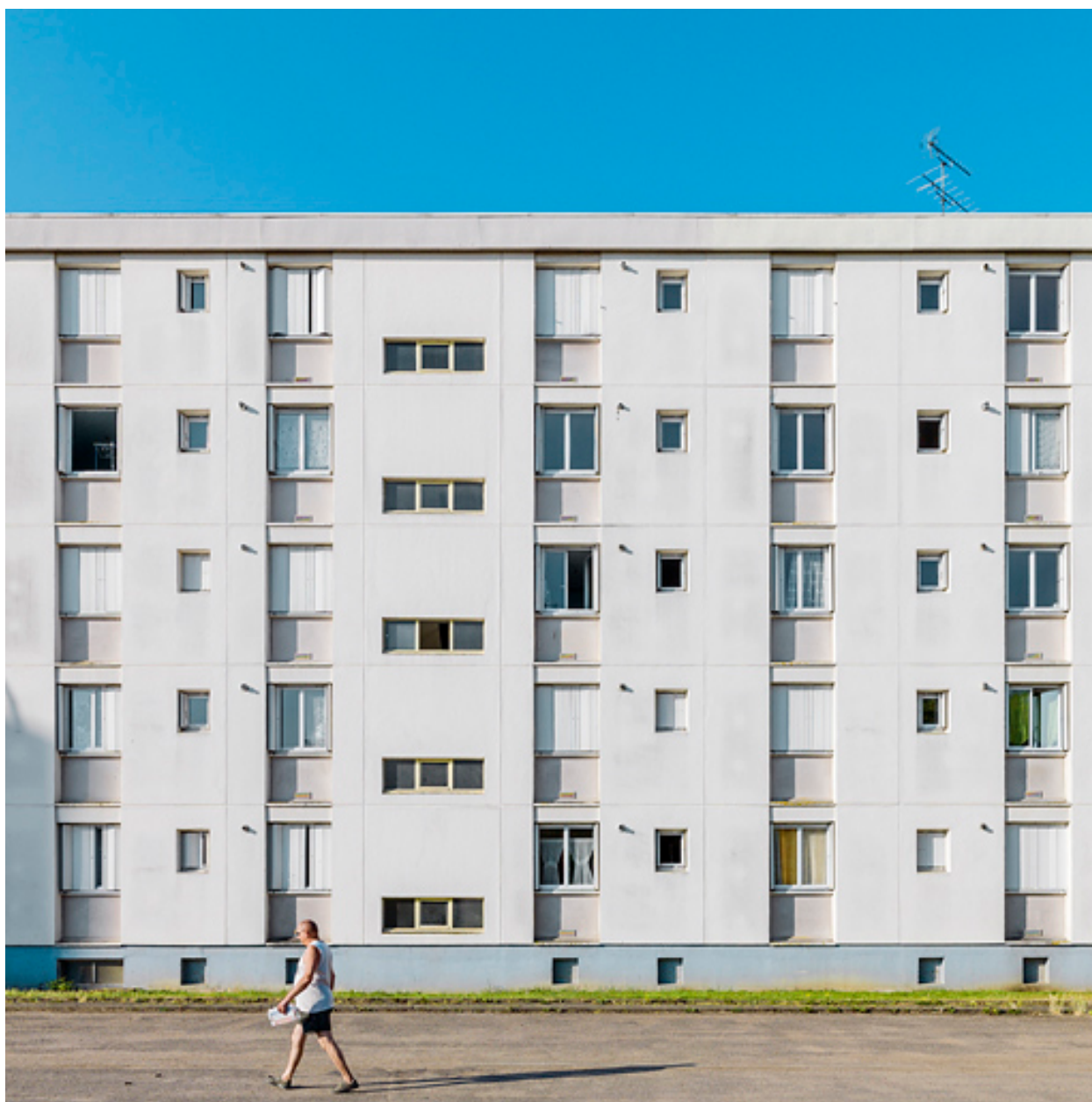
Bâtiment B-1, façade postérieure nord.
