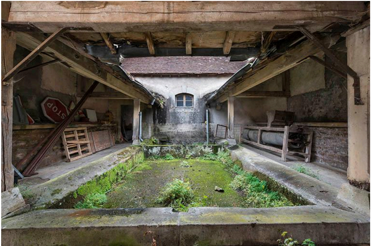
Le lavoir entouré de sa galerie couverte. La remise de matériel à incendie à l'arrière-plan.
