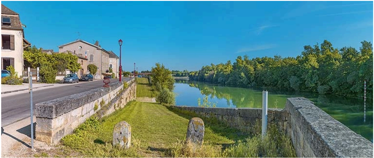
Quais de Verdun : la double rampe.
