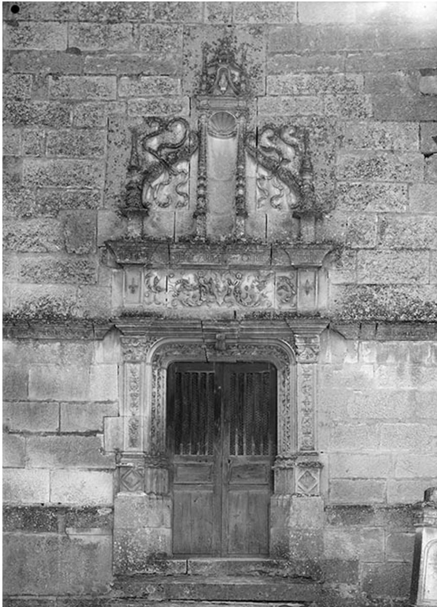
Portail d'entrée, vue d'ensemble.
