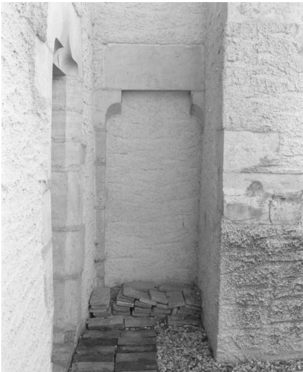
Elévation gauche, porte murée du chœur et porte de la chapelle
