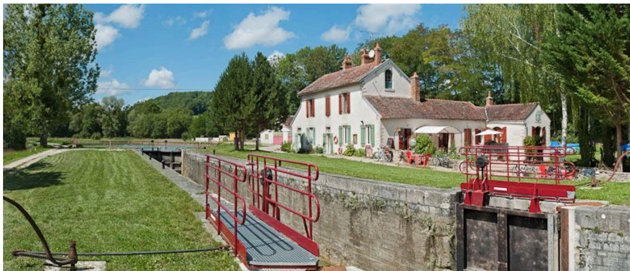
Vue d'ensemble du site d'écluse.
