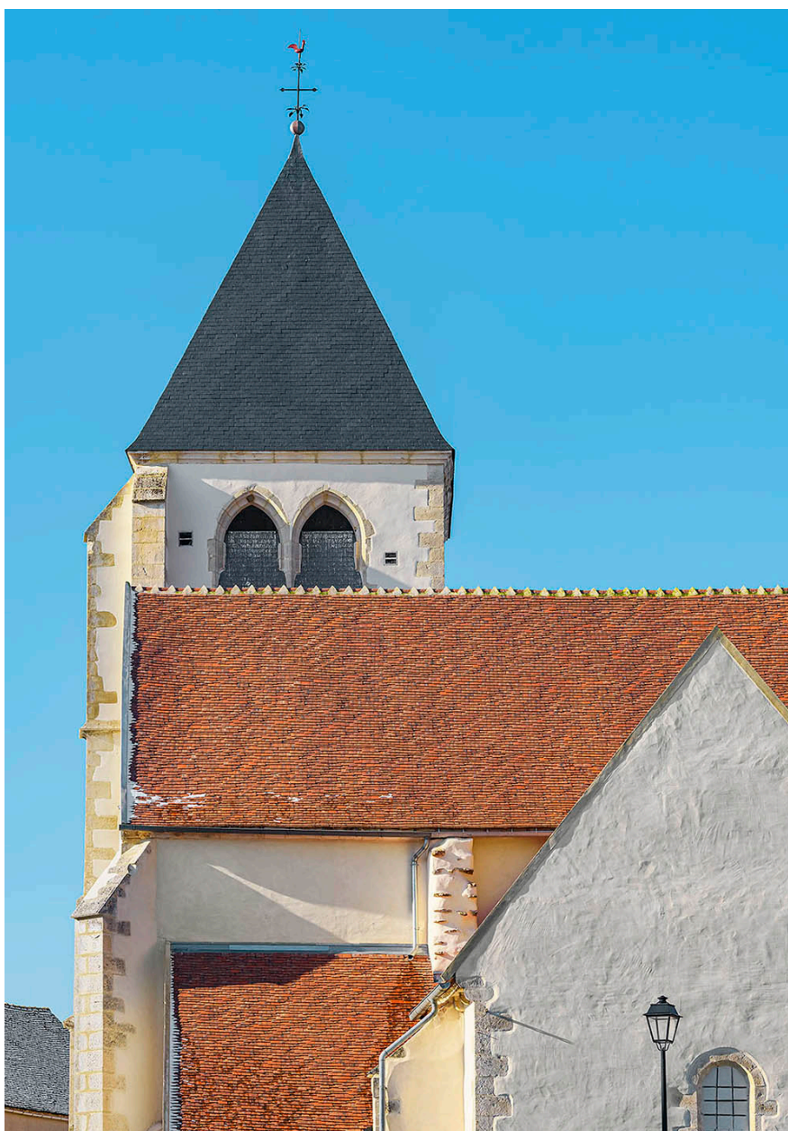
Détail de la toiture restaurée : vue depuis le chevet plat.
