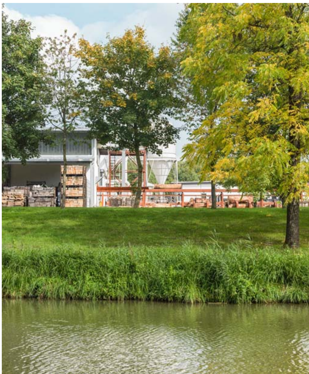
La scierie vue du canal.
