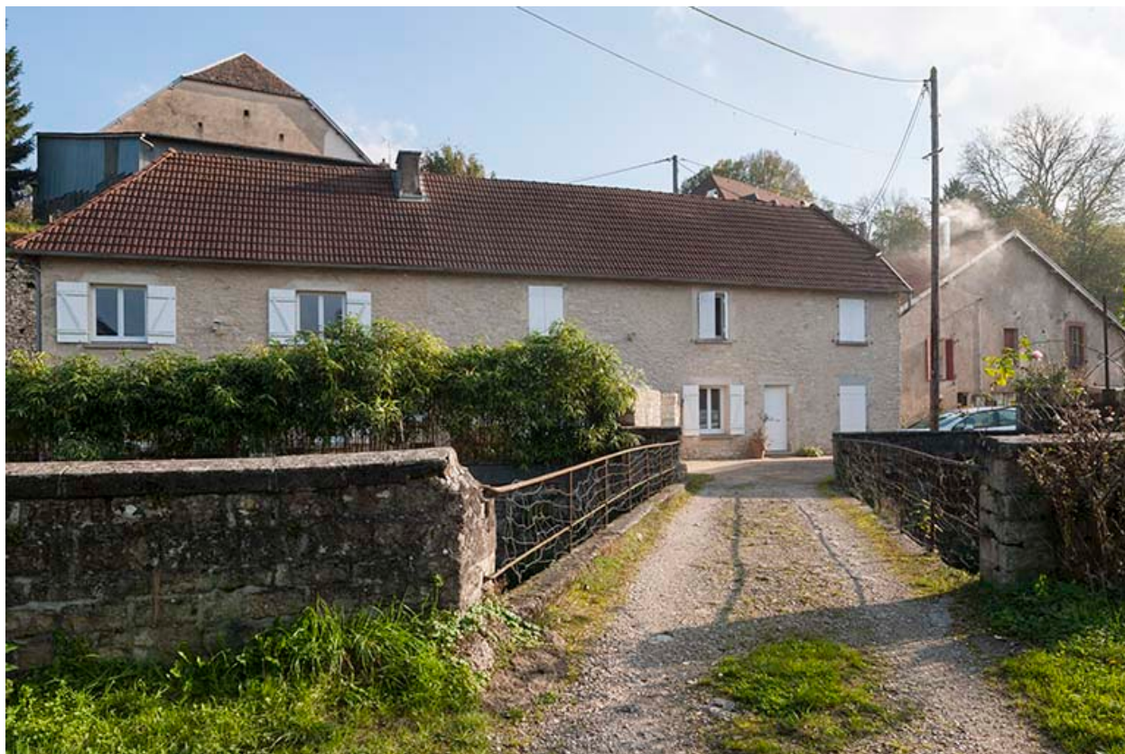
Façade ouest du logement patronal.
