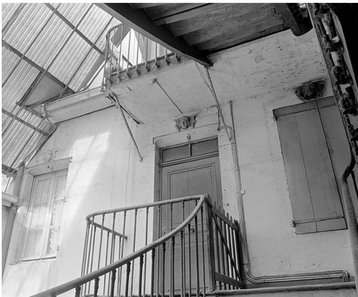
2e étage, élévation sur l'escalier.
