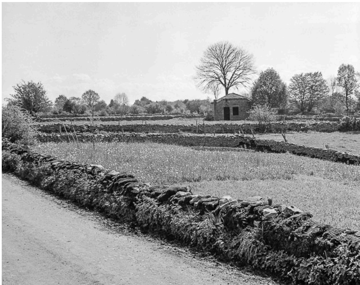
Mur en pierre sèche dit murger.
