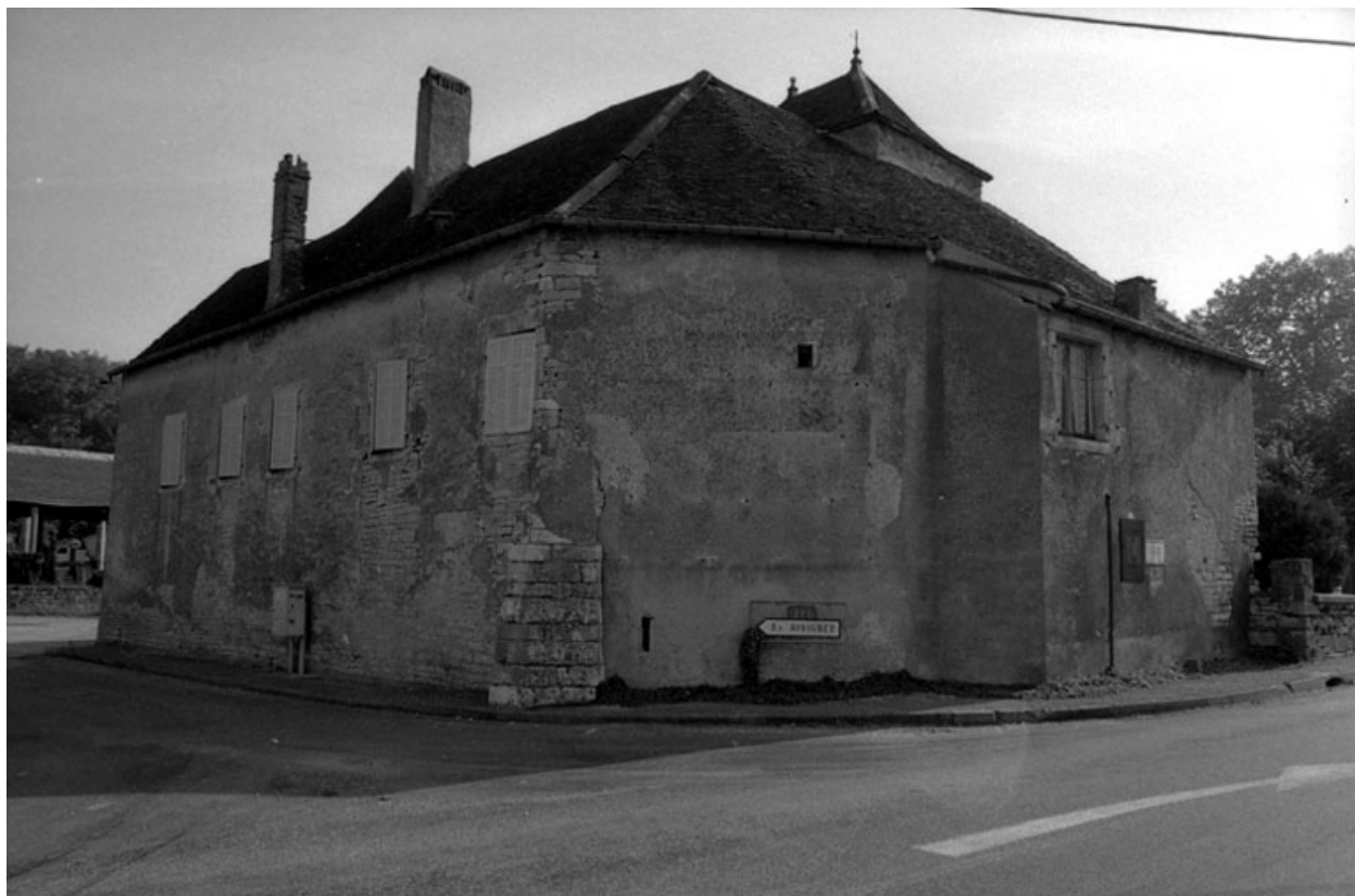
Maison située route de Besançon.
