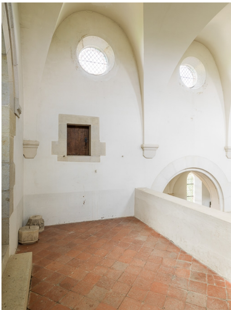
Tribune, oculus et accès aux combles.
