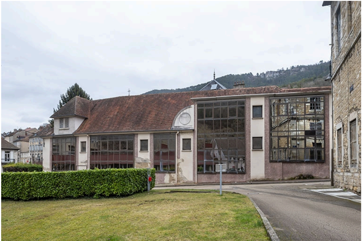
Façade sur la rue des Barres.
