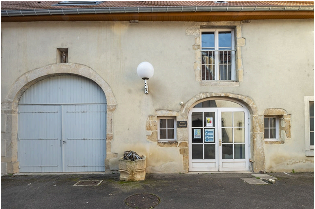
La façade du bâtiment situé au fond de la cour.
