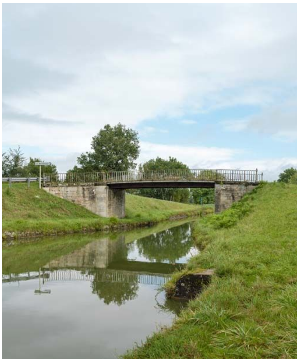
Vue d'ensemble du pont.
