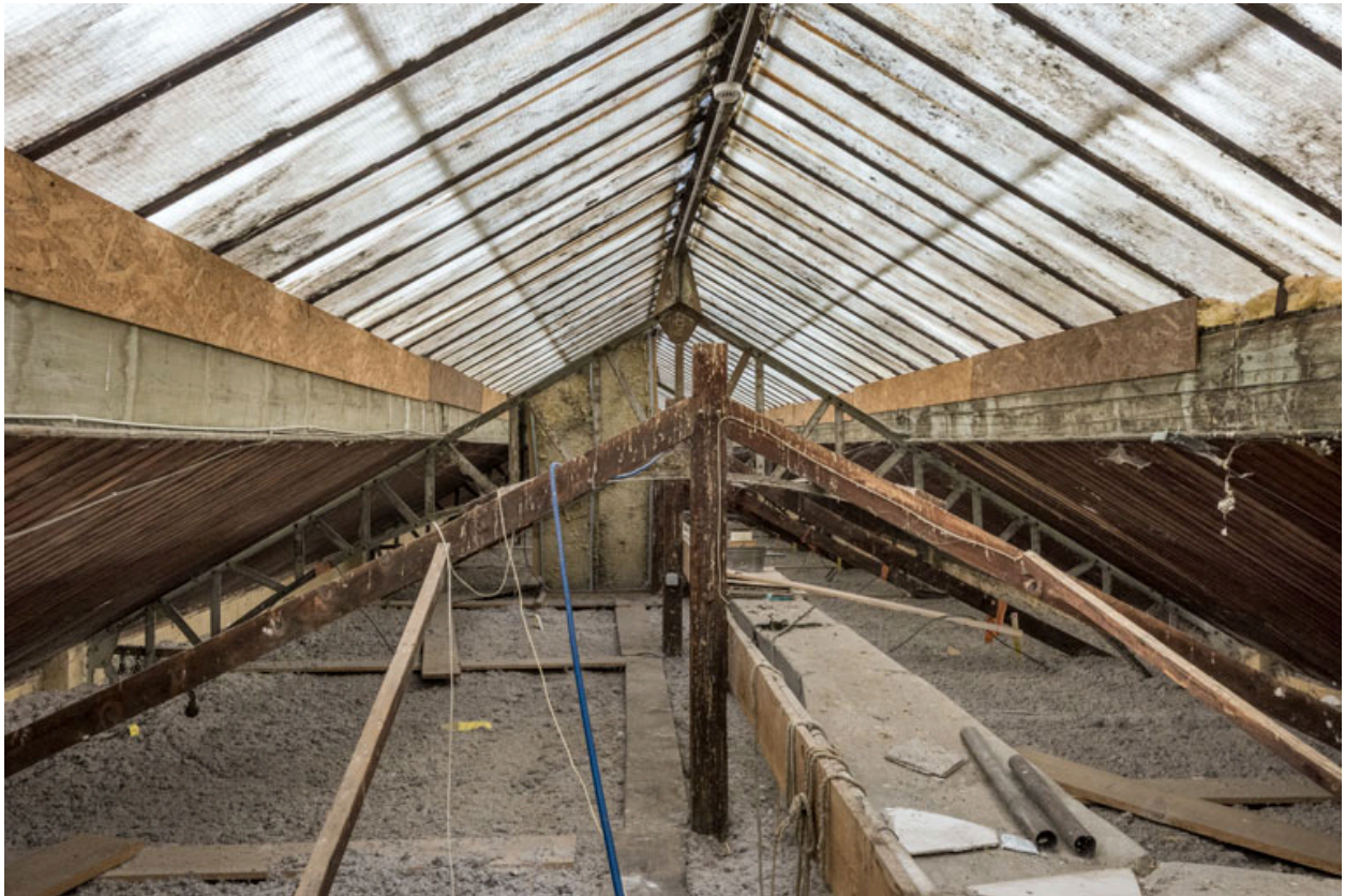
Charpente métallique et verrière, depuis le côté du quai.
