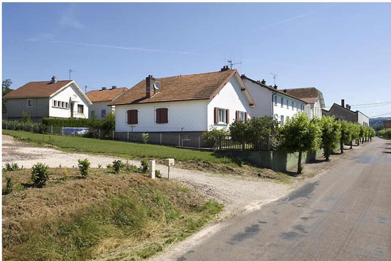
Logements. Vue d'ensemble depuis l'ouest.
