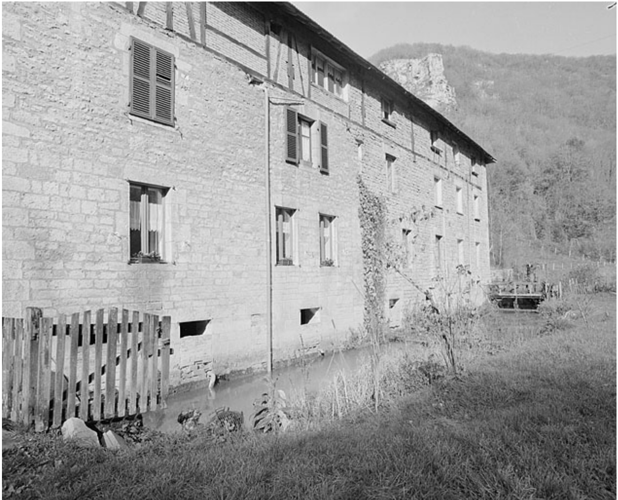
Façade sur le canal depuis le sud.
