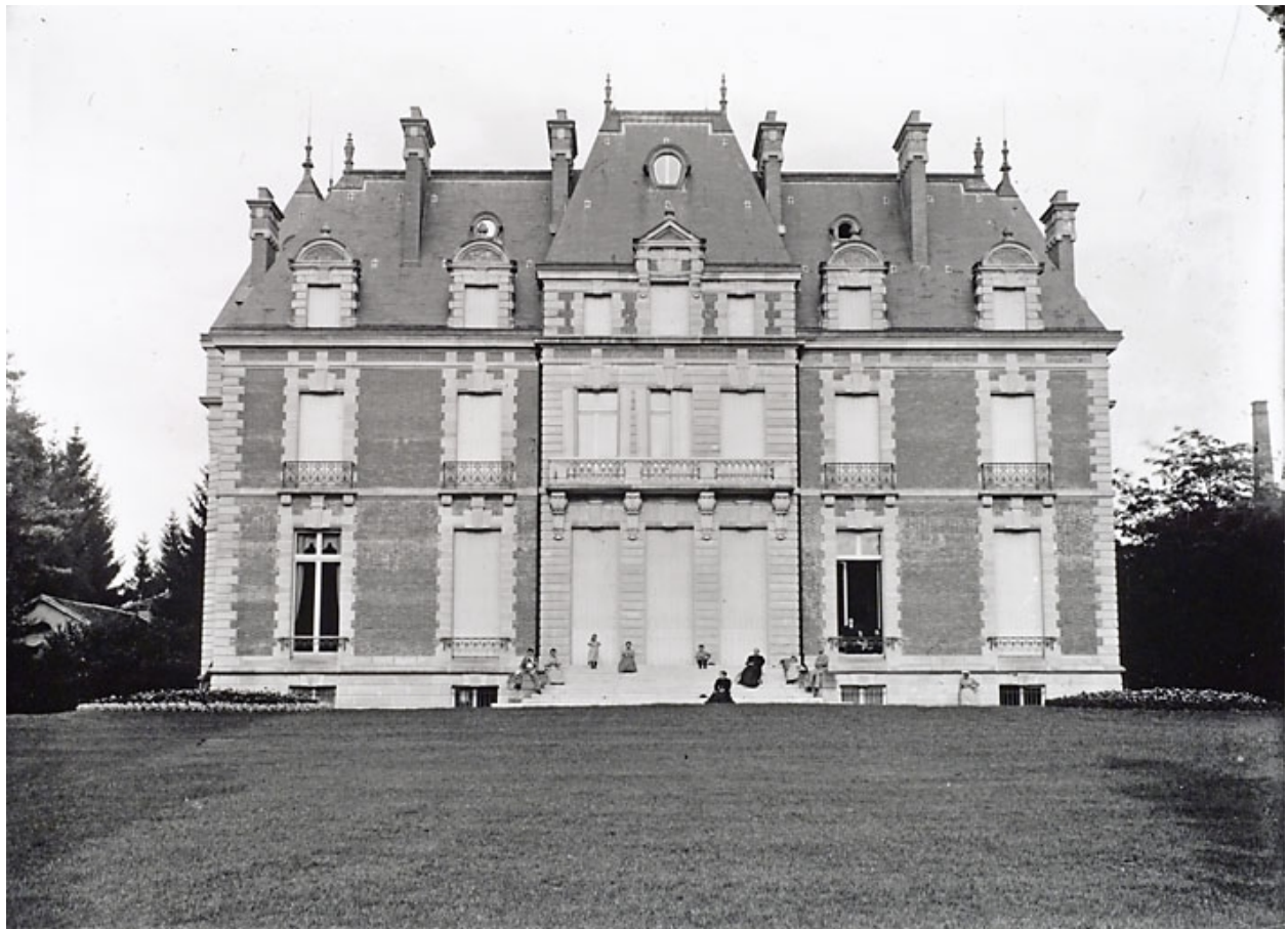
Façade occidentale de la nouvelle demeure patronale.
