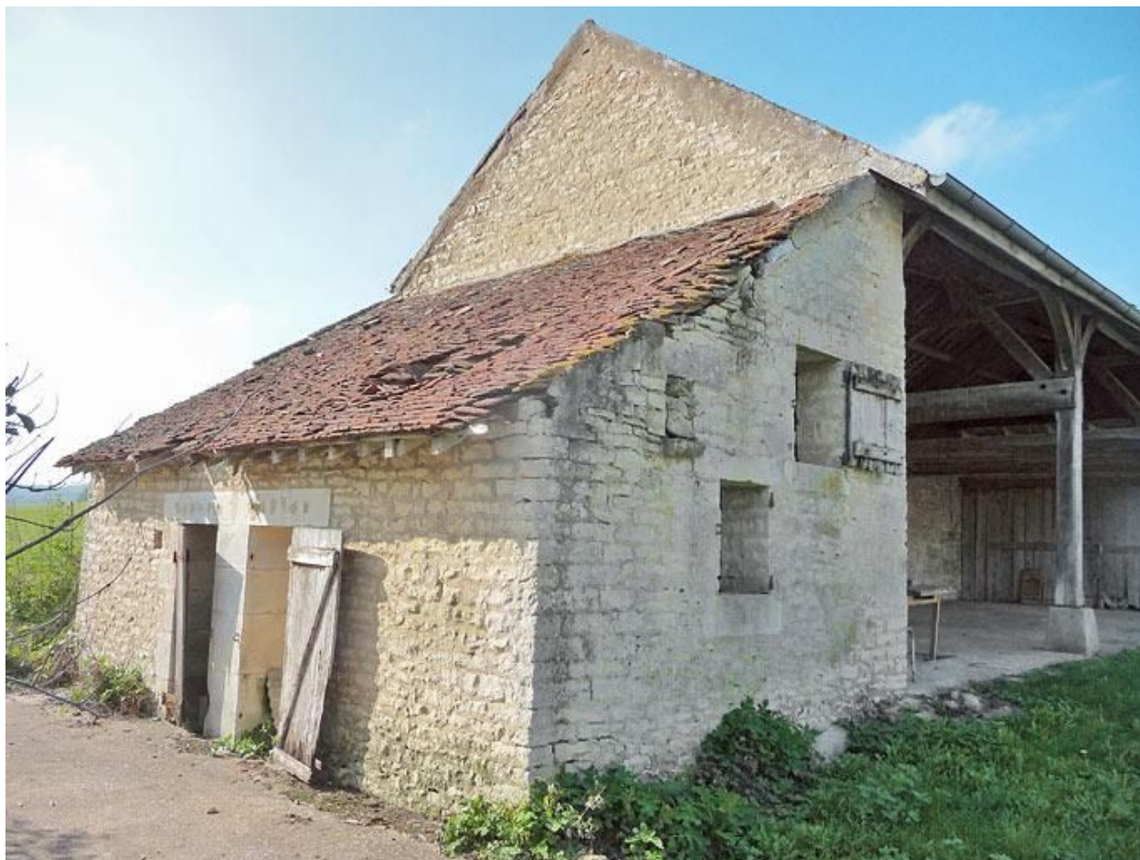
Petite dépendance prolongeant le hangar.
