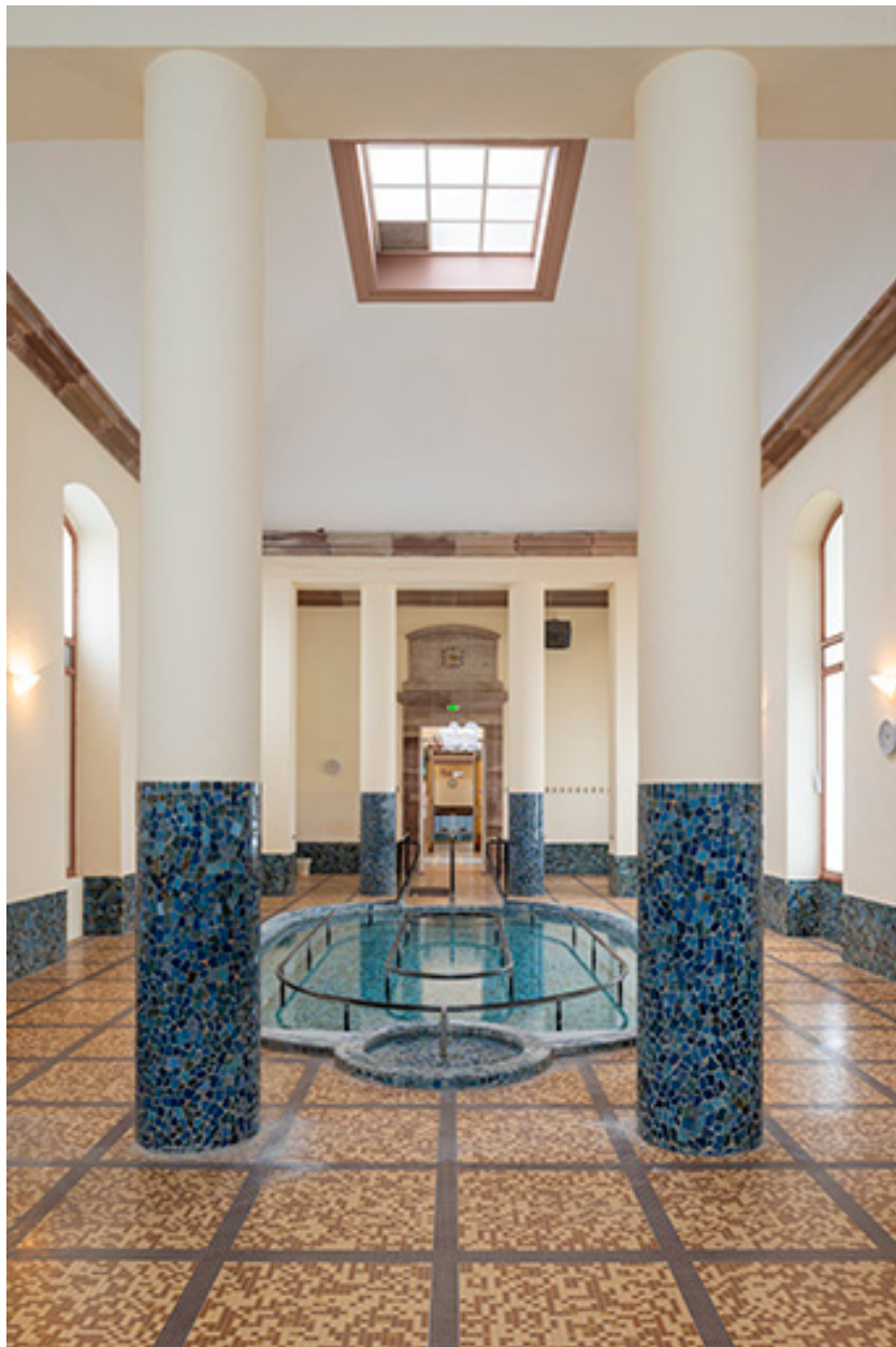
Piscine à l'emplacement du Grand Bain, colonnes remplaçant l'ancien mur ouest, vue en direction de l'est.
