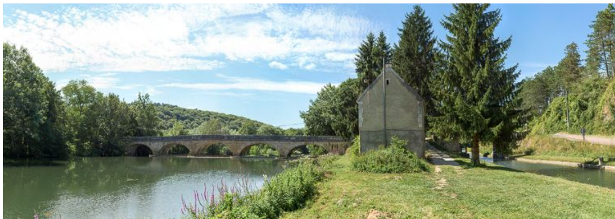
Site d'écluse de Merry-sur-Yonne : vue générale avec à gauche, le barrage sur l'Yonne et à droite, la maison de garde.
