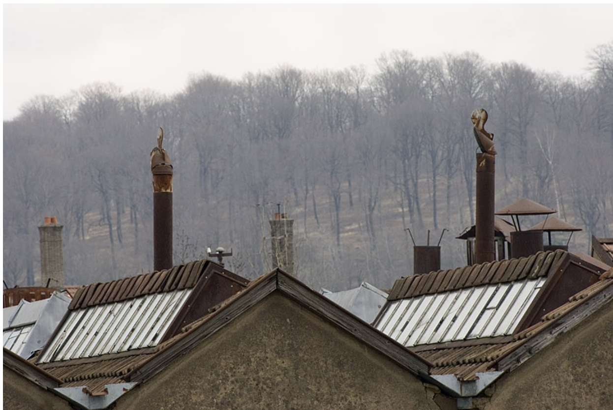
Détail des toitures et des cheminées métalliques.
