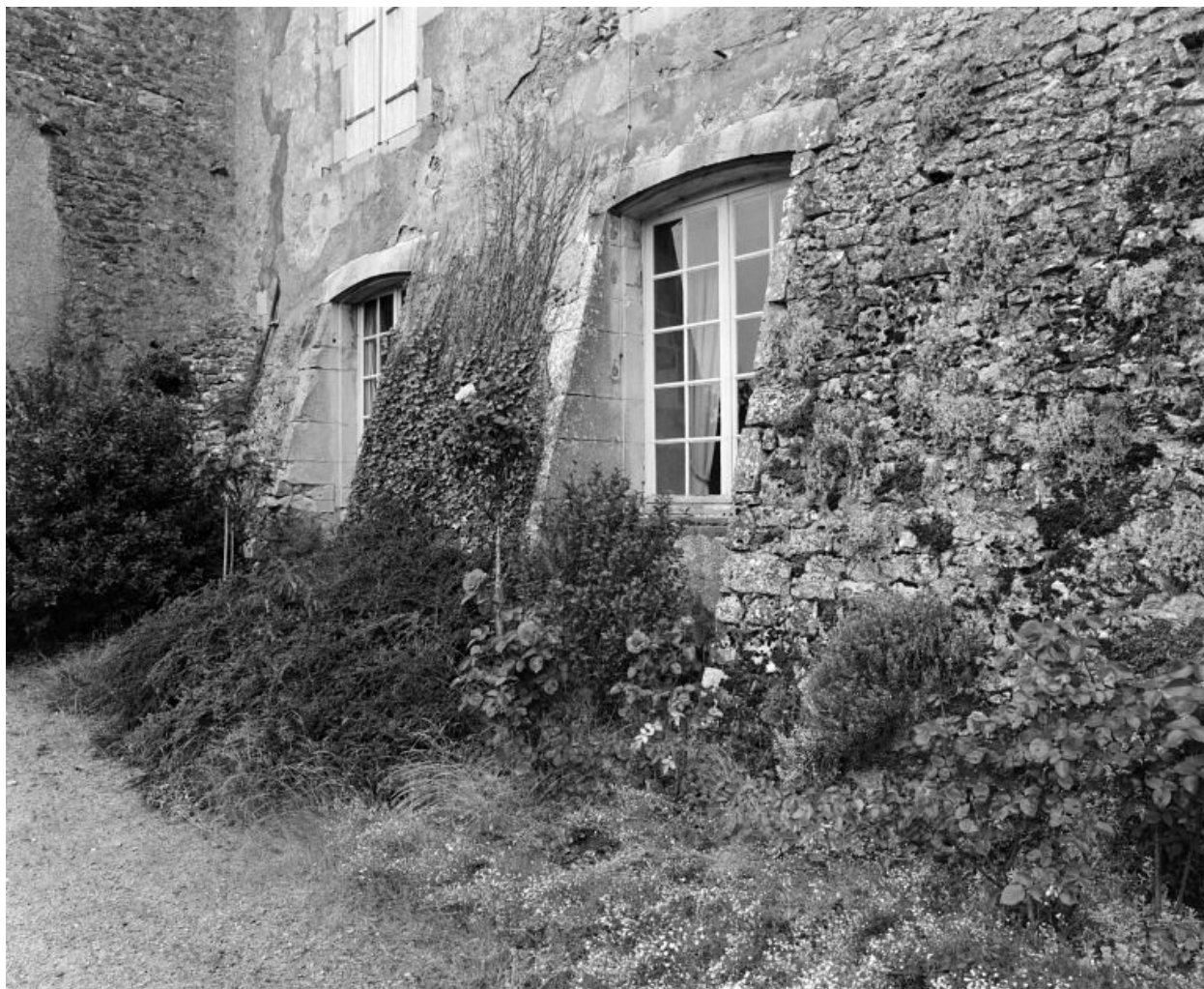
Bâtiment sud-ouest. Élévation antérieure, détail.
