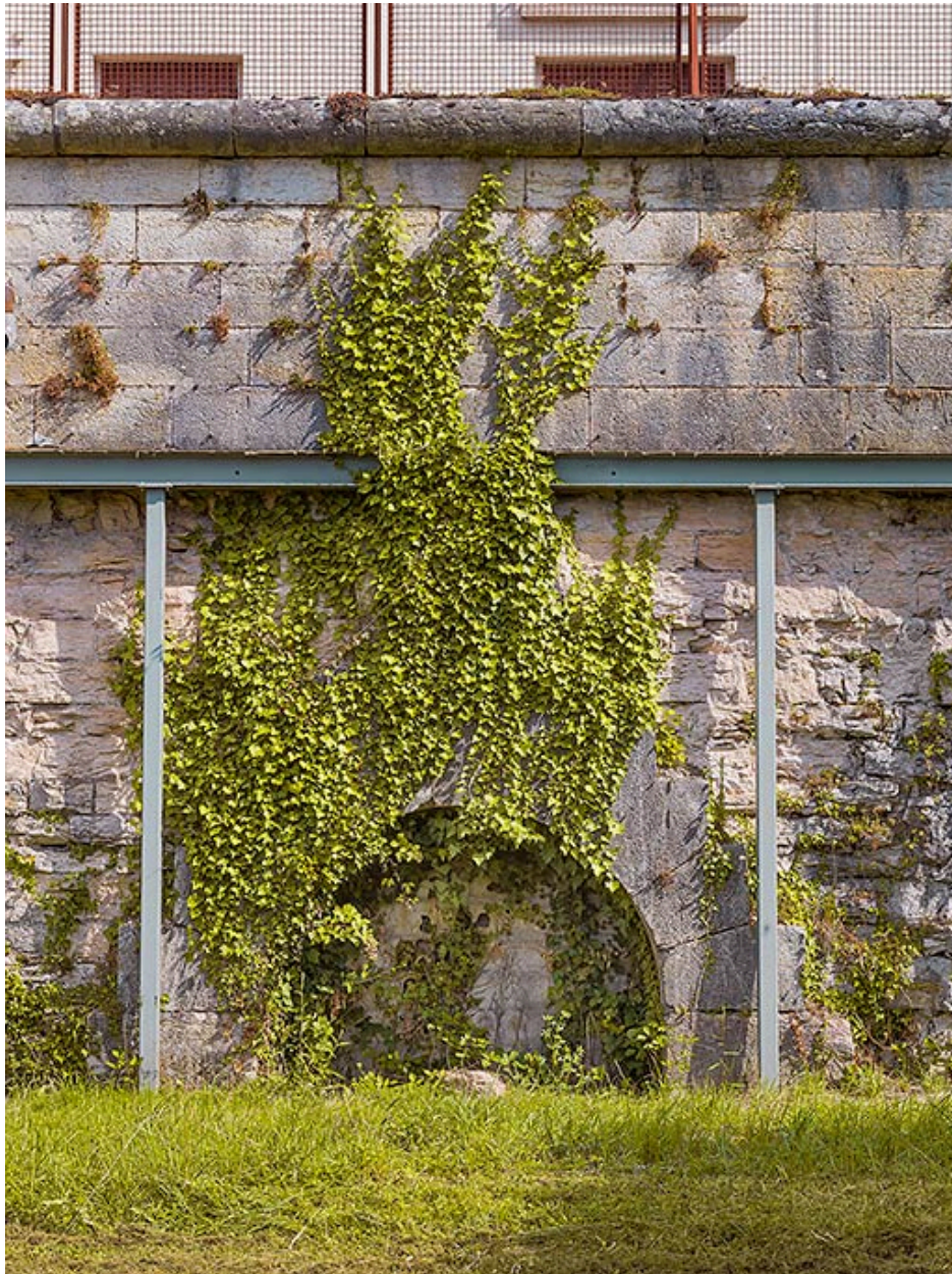
Le mur d'escarpe étayé (détail).
