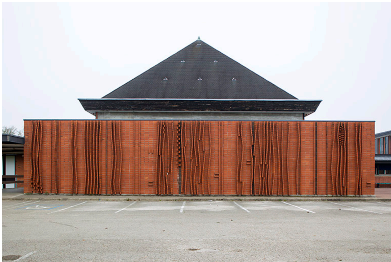
Vue de face du long mur sud.
